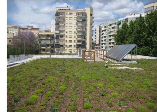
Figura 44. Cubierta vegetada en la azotea del colegio Gonzalbes Vera en el municipio de Xàtiva (Valencia). Proyecto AQUAVAL.
