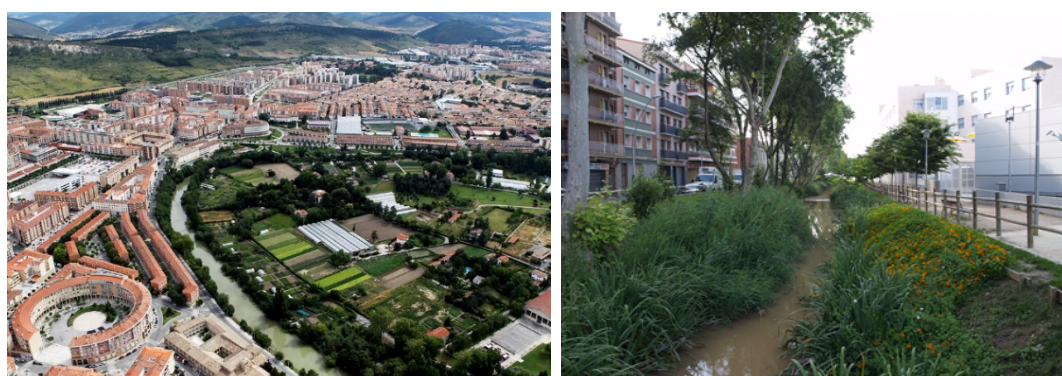
Fig.3.- Izqda., vista parcial del Parque Fluvial del río Arga en Pamplona, en cuyo diseño y ejecución se adoptaron medidas para la retención natural del agua (Fuente: Ayto. de Pamplona); Dcha., renaturalización de la red de drenaje urbano mediante técnicas SuDS (Área de Sabadell, Barcelona).
