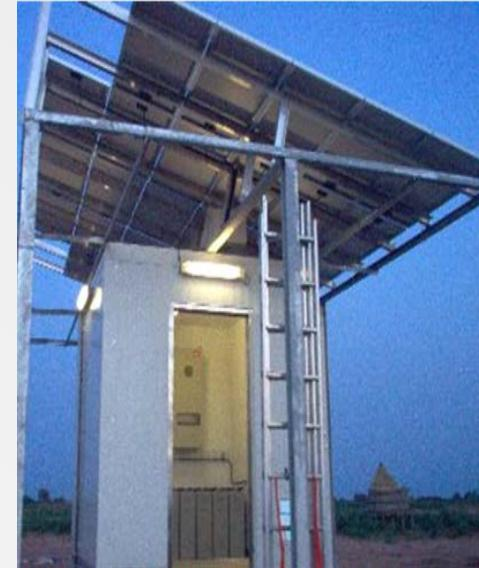
Un complemento importante de los paneles solares para la solución de bombeo es un inversor especialmente diseñado con variador de frecuencia integrado que permite al sistema de bombeo trabajar más horas desde cuando se tiene baja radiación solar por la mañana temprano y quedarse trabajando hasta la puesta del sol. Esto permite maximizar el rendimiento a un reducido precio ya que el sistema no requiere del almacenamiento de energía ni de otros elementos que encarecerían la instalación.
