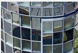
Las ventanas fluidicas de gran superficie cuentan con un líquido que circula por microcanales y que recolecta energía solar y térmica del ambiente y posibilita un intercambio de calor, todo lo cual favorece la eficiencia en el consumo de energía.
