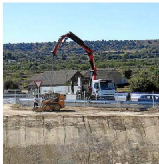
Los operarios ultimaban ayer los detalles del nuevo tramo. CONCHA SILVÁN
