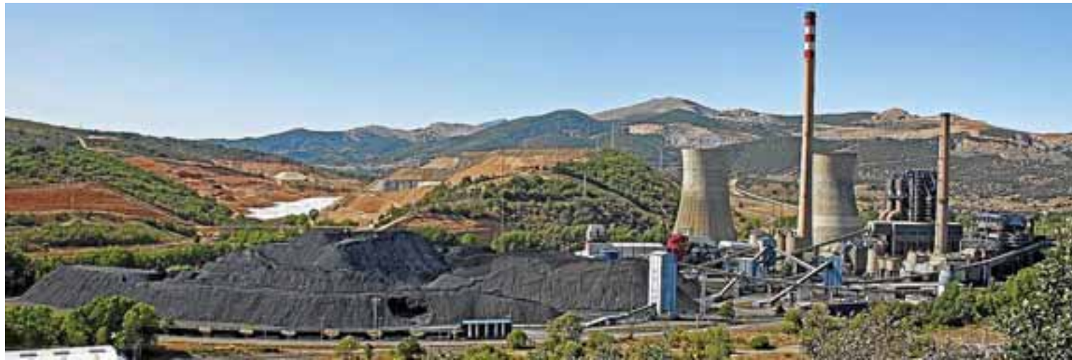
Toneladas de carbón acumuladas en San Román (León). El Gobierno primará a las eléctricas que quemen este combustible autóctono para producir electricidad.
