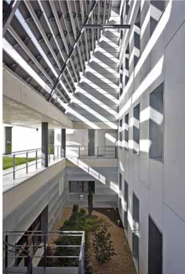
Instalaciones del Centro Nacional de Energías Renovables (Cener).
