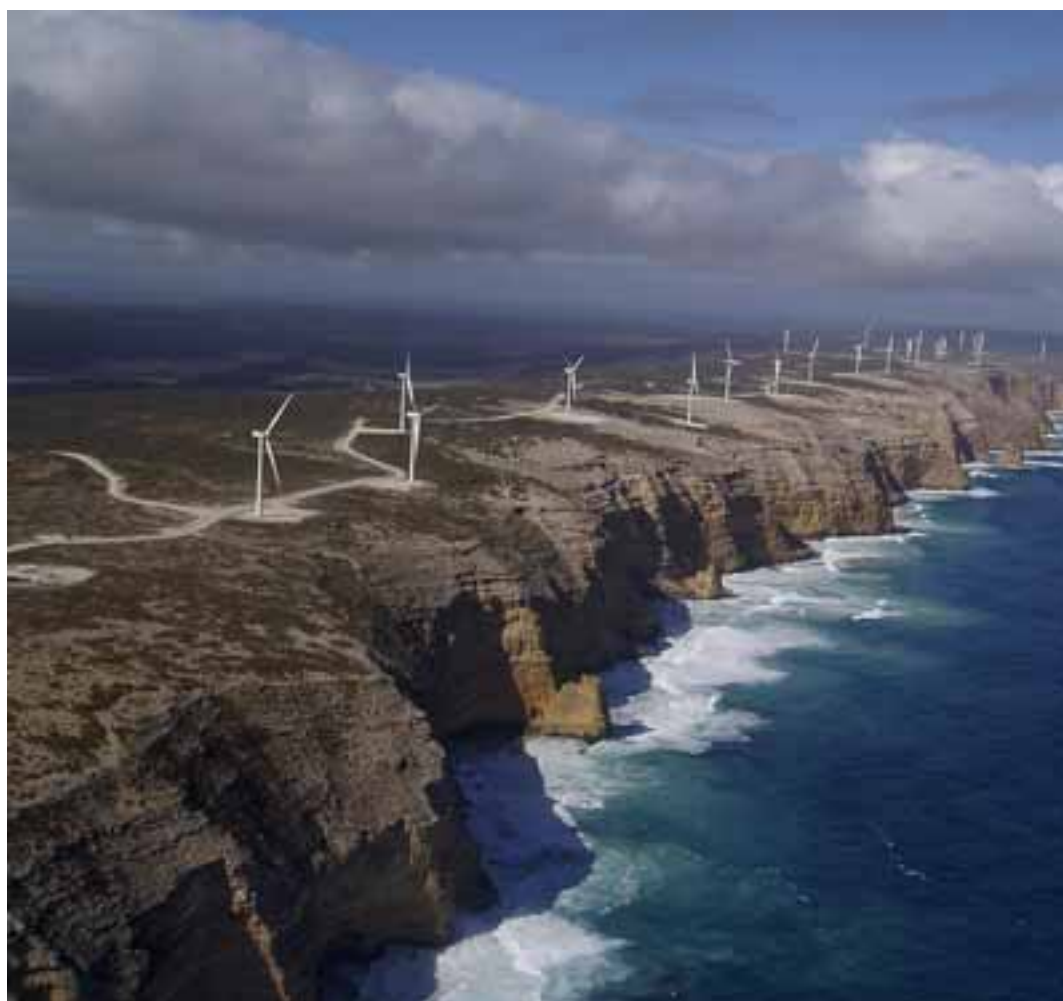
Parque eólico Central Rocks, de 66 MW de potencia, propiedad de la firma Acciona y situado en el sur de Australia.
