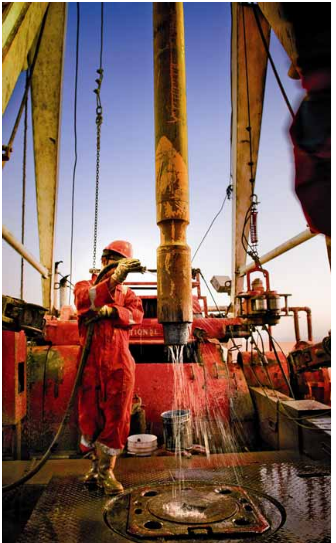
Un operario de Repsol YPF trabajando en un pozo de petróleo.
