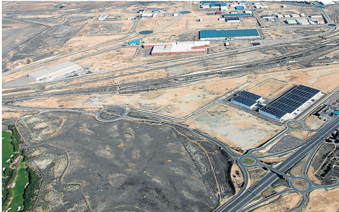
Los suelos que se urbanizarán para Amazon ocupan la mancha gris de la fotografía. HA
