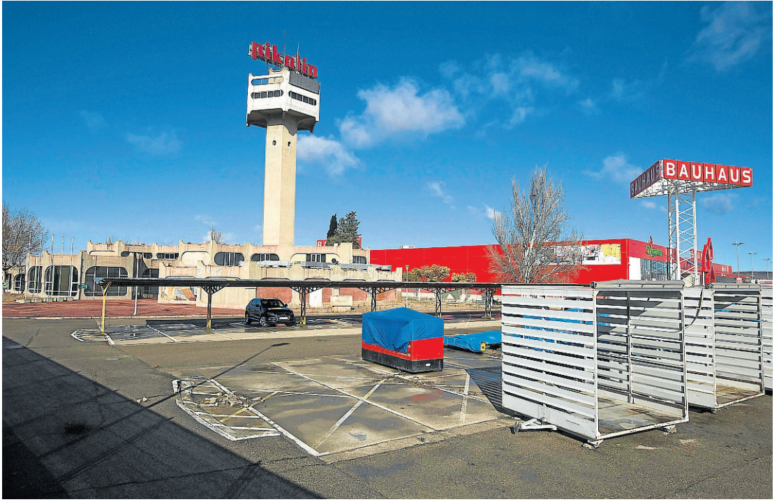
Vista de los terrenos de Pikolin donde se construirá el futuro 'outlet'. TONI GALÁN
