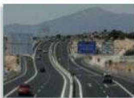
7. M-501 (Madrid). El Tribunal declaró ilegal el desdoblamiento de una carretera por hacerse sin evaluación de impacto ambiental.
