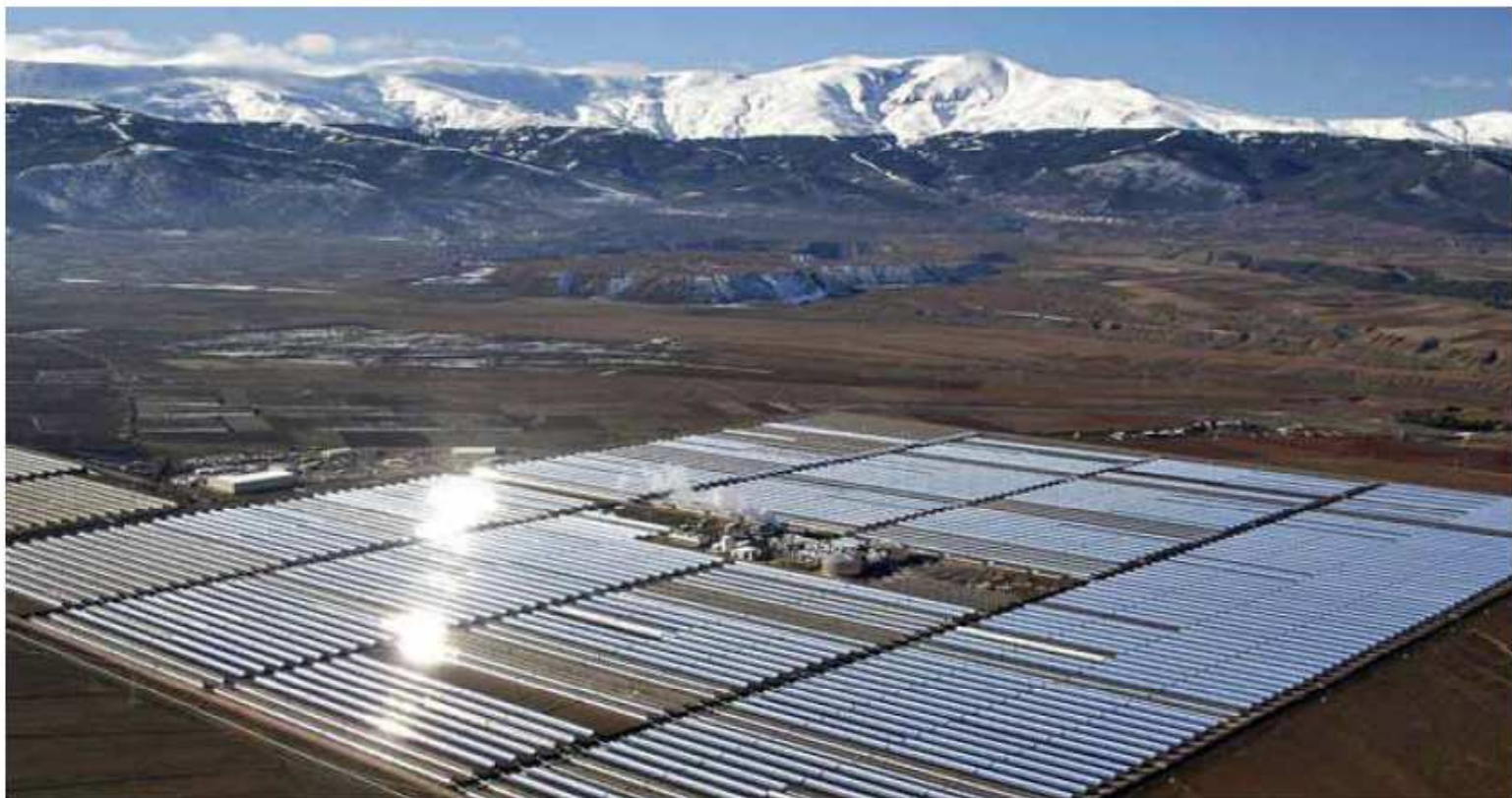
Central termosolar de ACS en El Marquesado (Granada), la primera de colectores cilindro-parabólicos conectada a la red.
