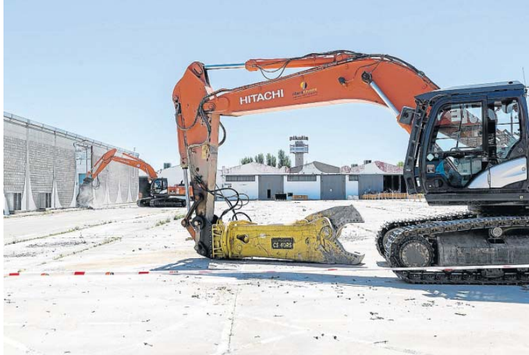
Las máquinas derriban una de las antiguas naves de Pikolin en la carretera de Logroño. GUILLERMO MESTRE
