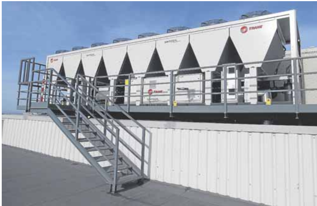
Máquina de climatización enfriadora aire-agua en la planta ubicada en Plaza. MANN+HUMMEL IBÉRICA
