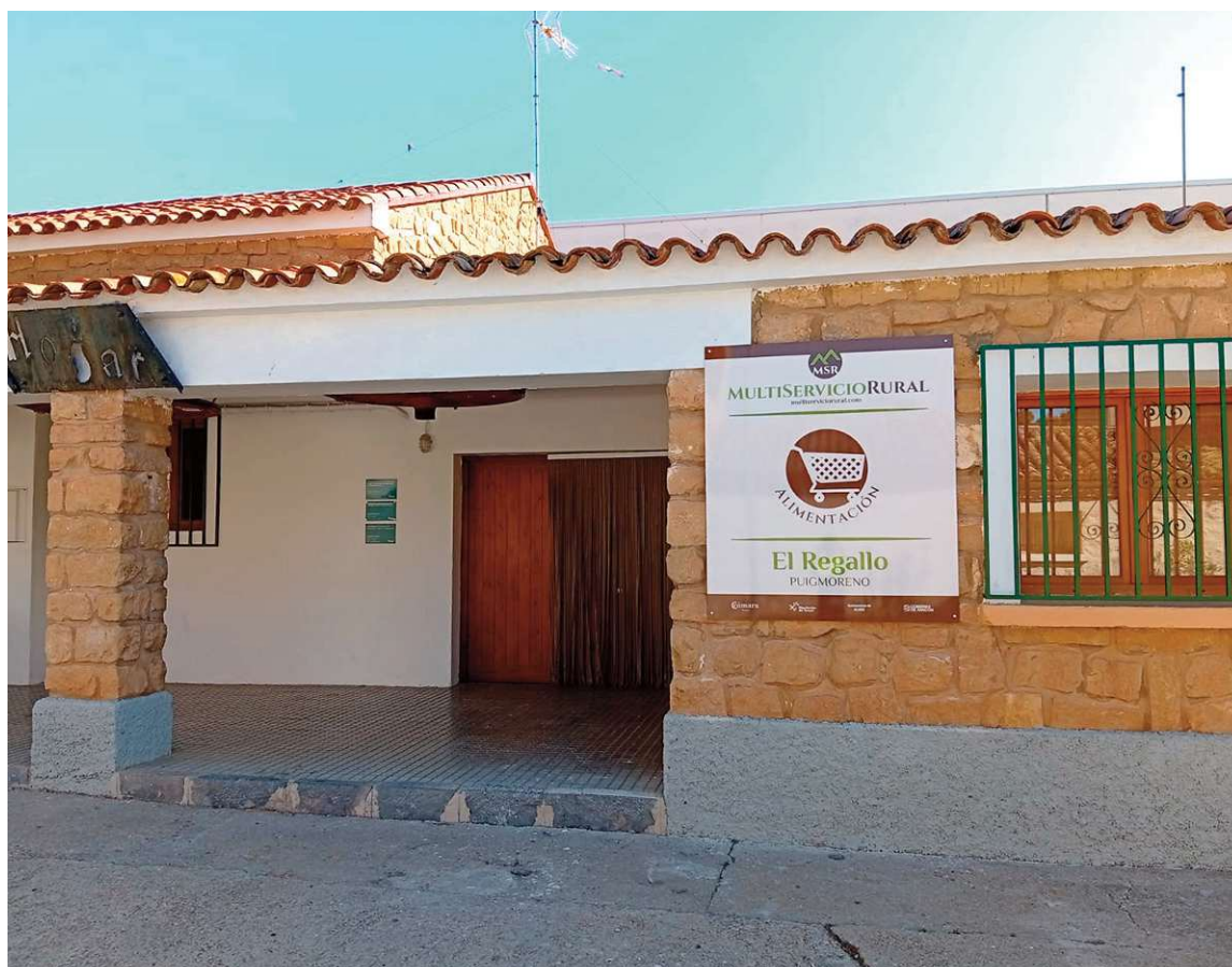
Fachada del multiservicio de Puigmoreno 'El Regallo'. Ayuntamiento de Alcañiz
