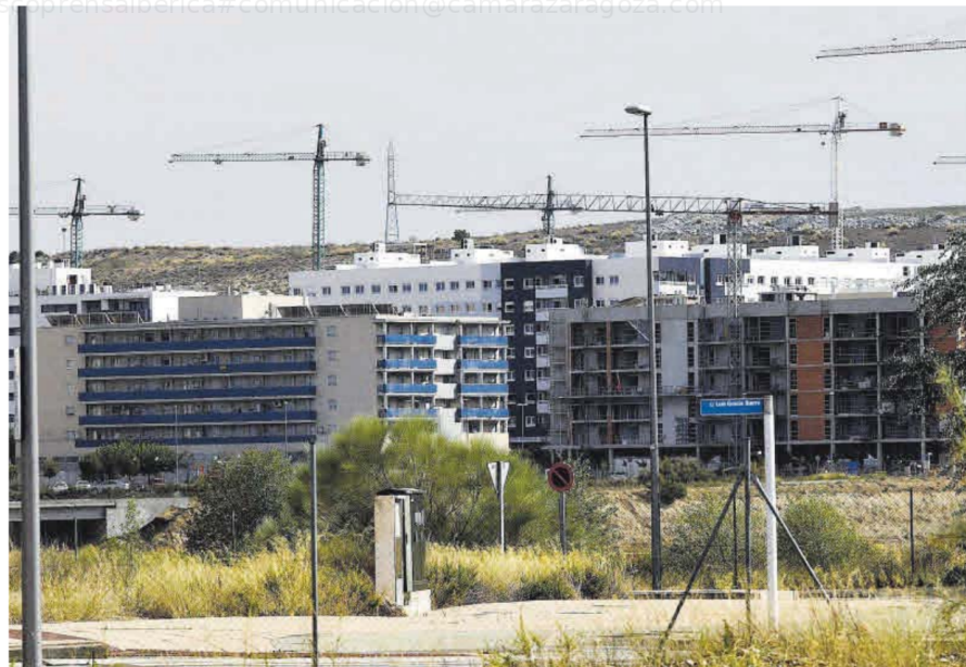
Obras en el barrio zaragozano de Arcosur, que tiene reservados más de la mitad de sus suelos para construir VPO.
