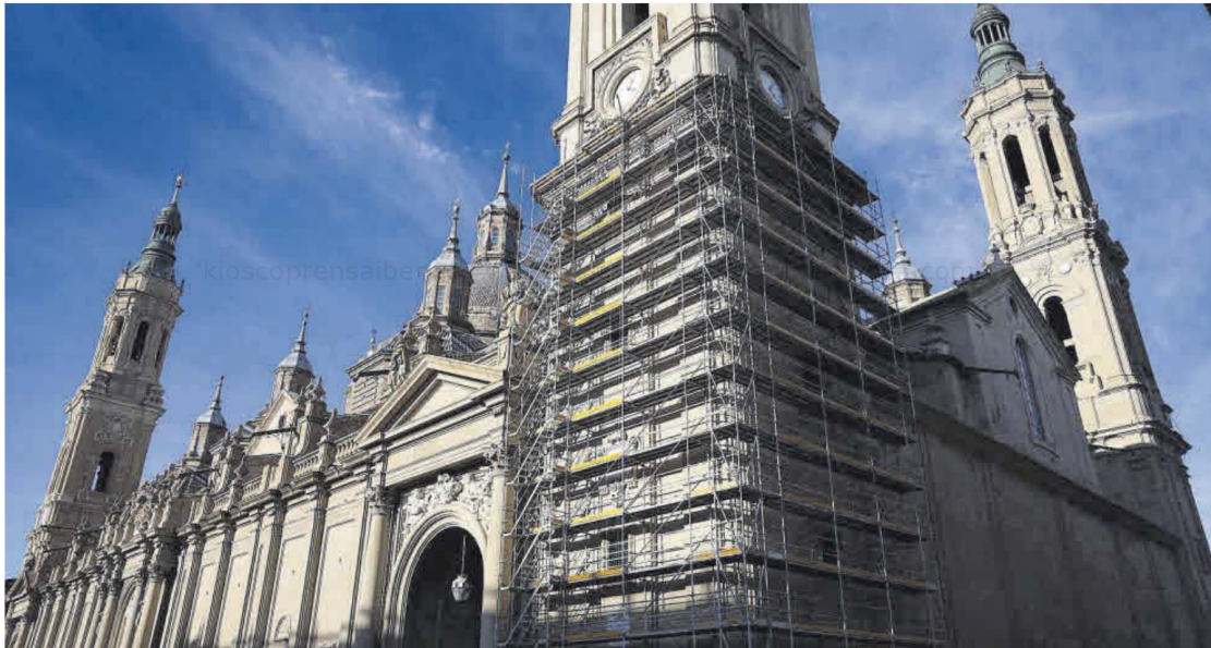
La basílica del Pilar, ayer, con una de sus torres rodeada por andamios.
