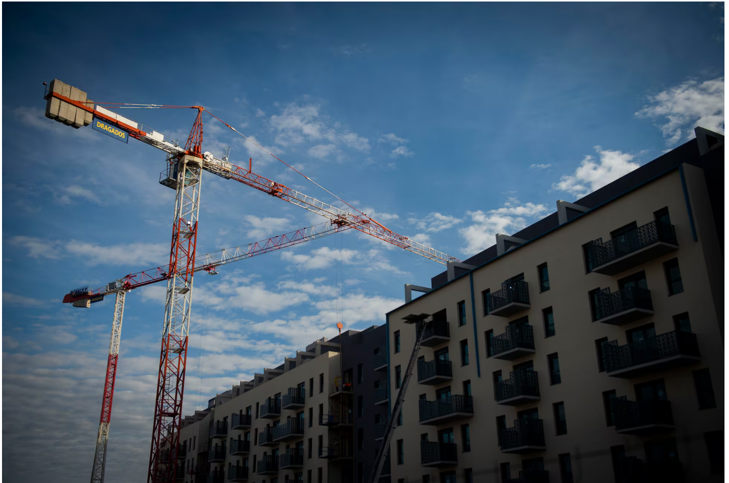
Construcción de unos bloques de viviendas en Cuatro Vientos (Madrid). JUAN BARBOSA
