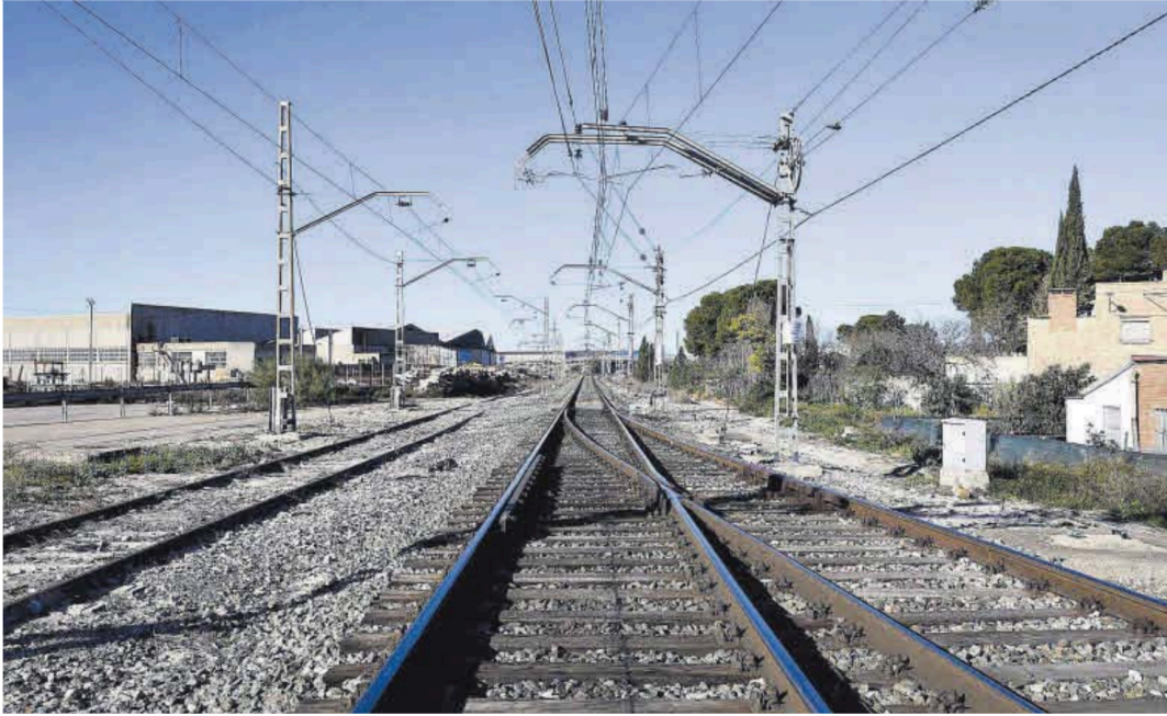
Vía del ferrocarril convencional junto al Parque Tecnológico del Reciclado, donde Megasa tiene ubicada su factoría.
