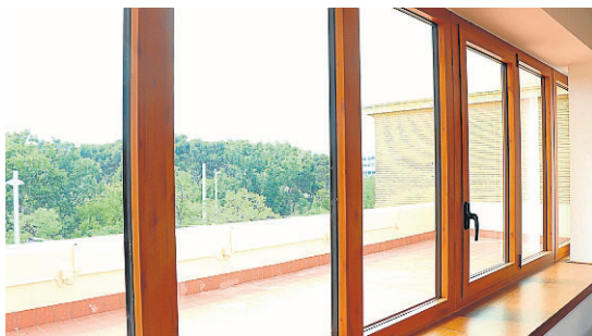
Las ventanas se han renovado. CÁMARA DE ZARAGOZA
